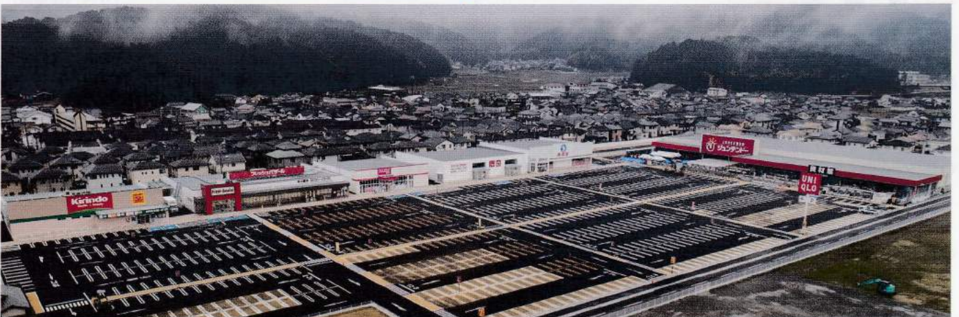
▲ 広大な敷地に900台を超える駐車スペースとジュンテンドーをはじめとする6店舗が並ぶ
