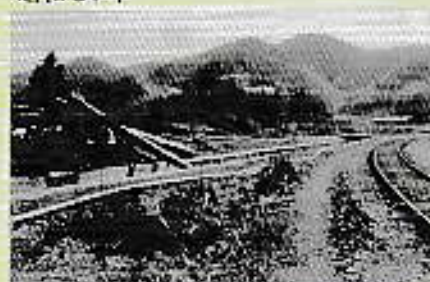
建設中の舞鶴工業高等専門学校 昭和40年
