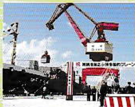
西港に多目的クレーン完成 平成元年
