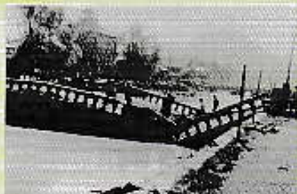
台風13号で壊れた万代橋 昭和28年
